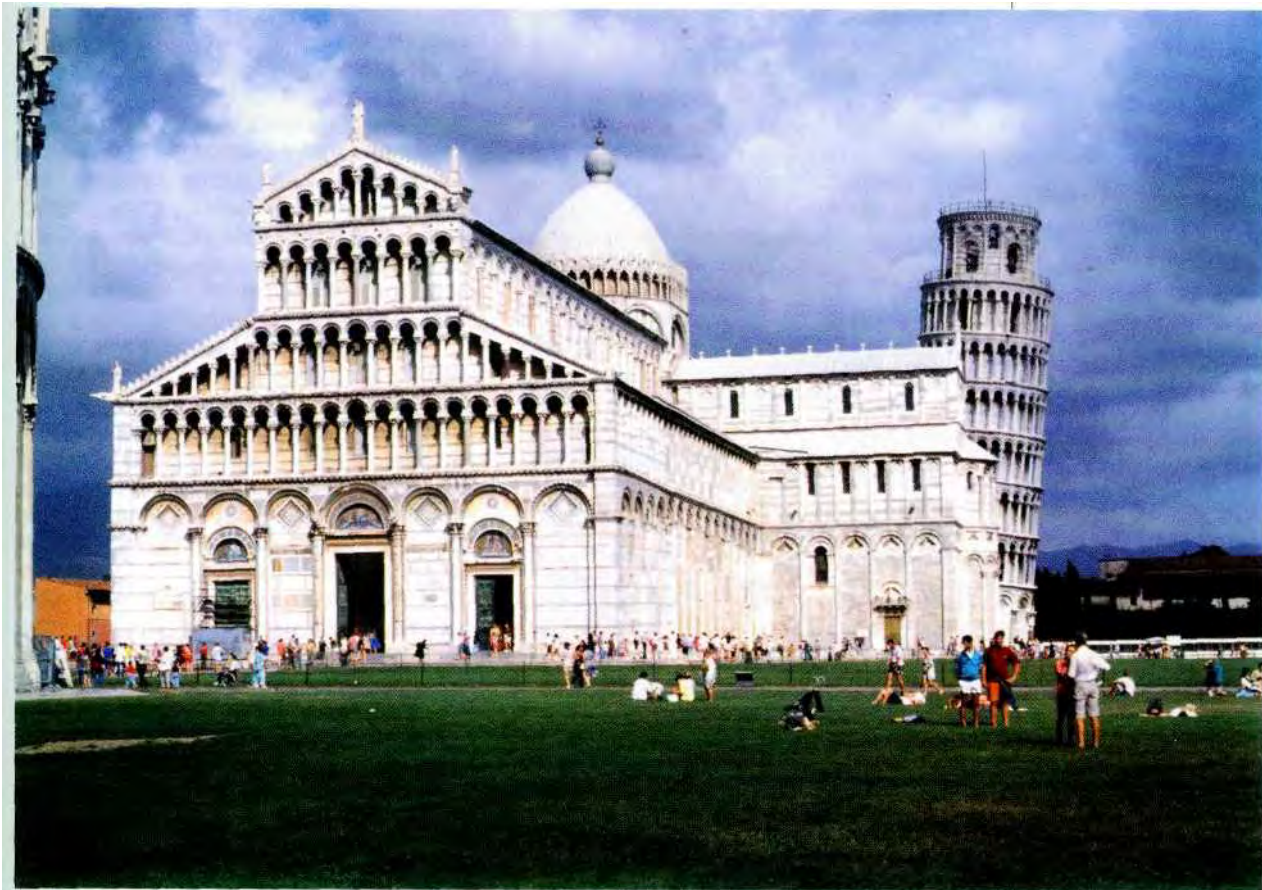
Собор и башня в Пизе. Начало строительства — 1063 г.
